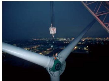
Rotorblattmontage, Quelle: Multibrud GmbH
