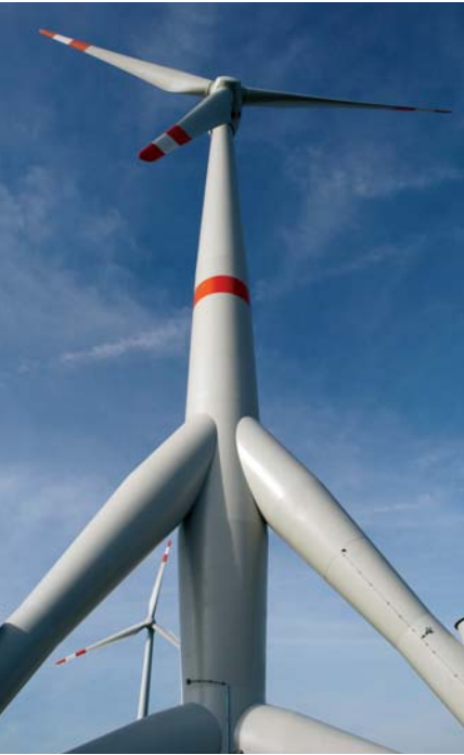
5 MW-Anlage M 5000 auf einem Tripod-Testfundament, Quelle: Multibrid GmbH
